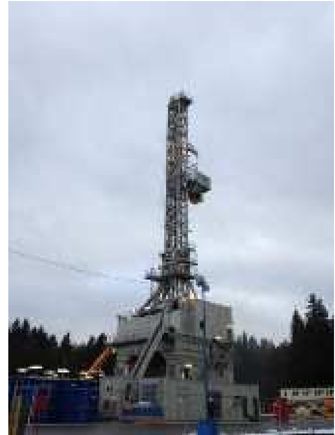
Bohrung Geretsried: nur auf Fazies gebohrt
