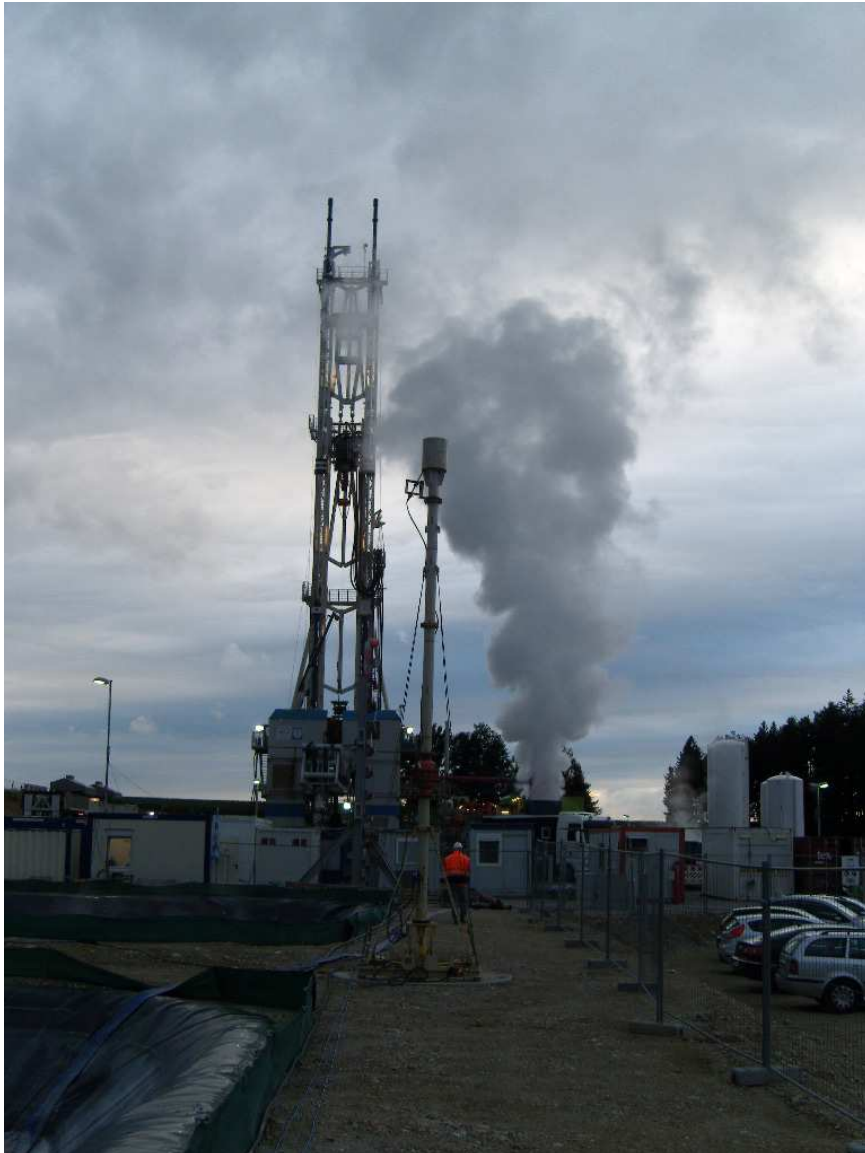
1. Reinigungsift nach Säuerung am 12.07.2012
