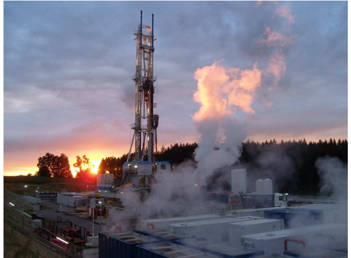
1. Reinigungsift nach Säuerung am 12.07.2012
